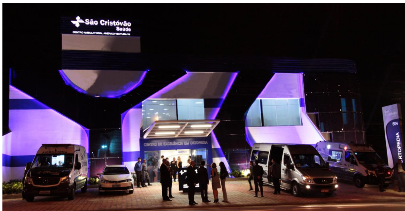
Fachada do CAAV VII – Centro de Ortopedia
